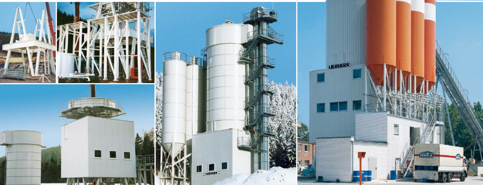
Montaje de una planta Betomat II.
