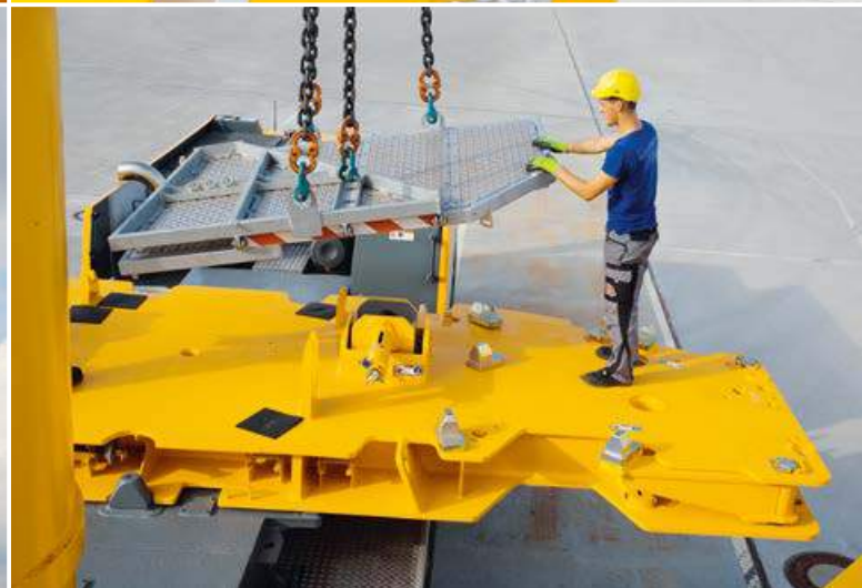
Automontaje de pasarelas
