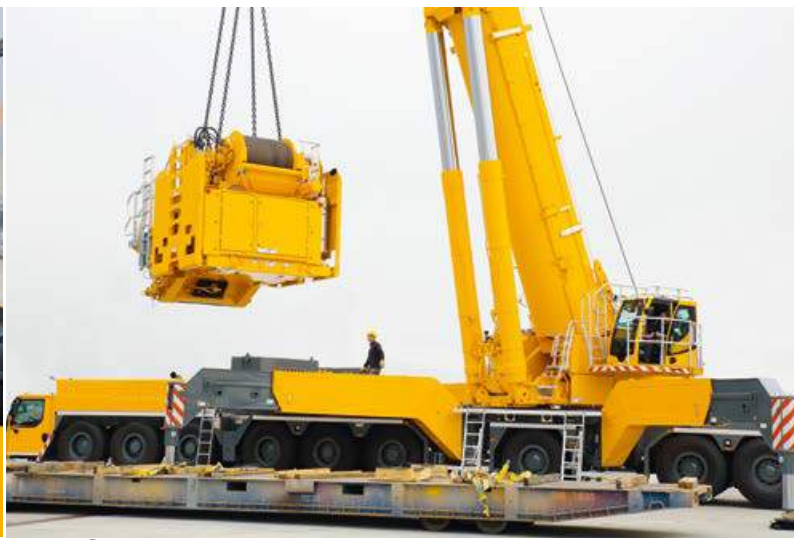
⑥ Automontaje de bastidor de contrapesos a través del agregado
